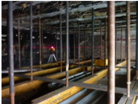
Verifica della deformazione dei travetti di un solalo interno mediante livella laser.
