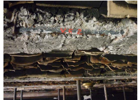
Verifica delle dimensioni e della tessitura delle armature con asportazione degli strati superficiali di calcestruzzo.
