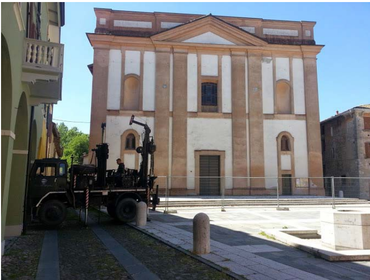
Esecuzione di prova penetrometrica statica.
