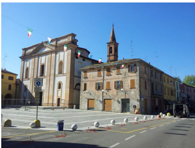
Panoramica ed ubicazione chiesa di San Martino Vescovo.
