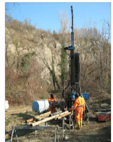
Sondaggio geognostico a carotaggio continuo verticale esterno cava
