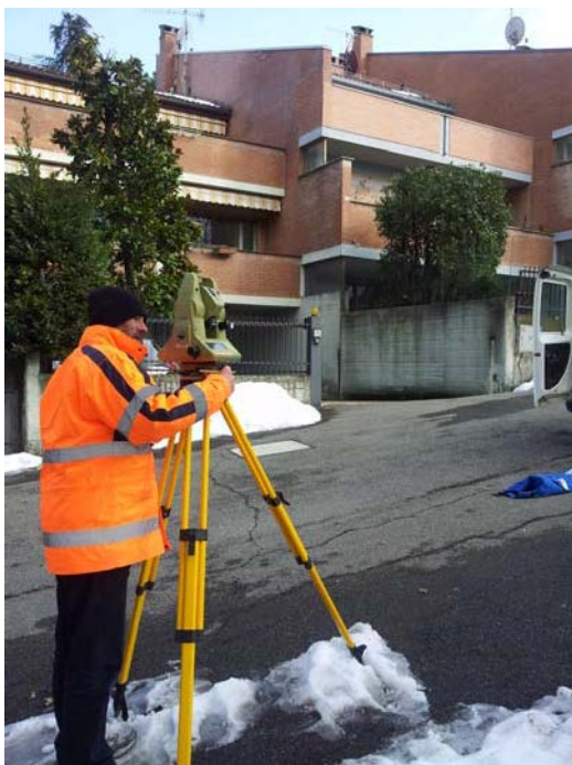
Rilievo topografico con stazione totale di misura Laica TCA1700 per il controllo delle deformazioni e degli spostamenti delle strutture esistenti all'intorno della ex cava, prta la verifica del mantenimento delle condizioni di sicurezza di persone e opere
