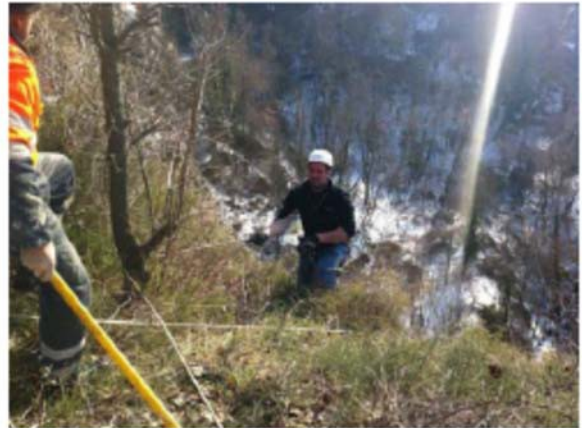
Operazione di disaggio manuale di elementi rocciosi per messa in sicurezza dei fronti rocciosi Interni ed esterni cava
