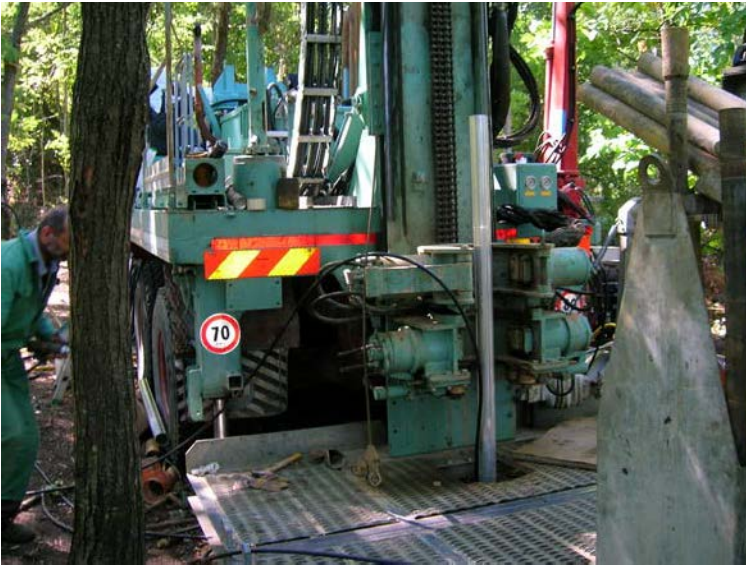
Esecuzione di perforazione a carotaggio continuo.
