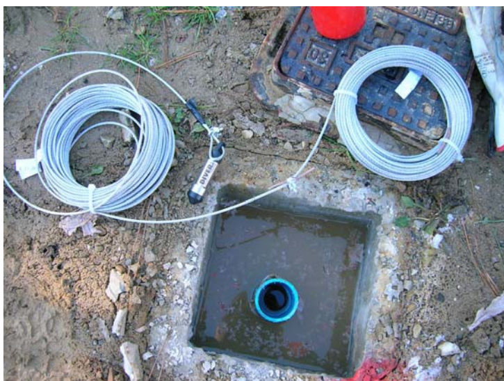
Installazione strumenti atti alla misurazione in continuo del livello piezometrico (diver) per il monitoraggio delle falde.
