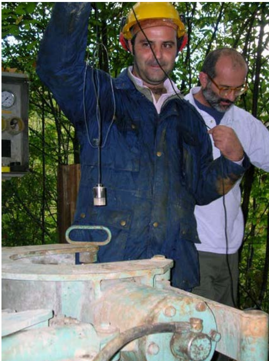
Utilizzo di una microcamera all'interno del foro di perforazione per la verifica di non ostruzione del foro al fine di installare il tubo inclinometrico.
