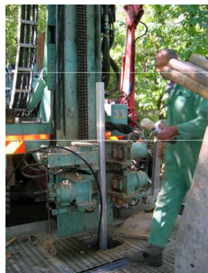
Installazione di tubo inclinometrico in verticale di perforazione.
