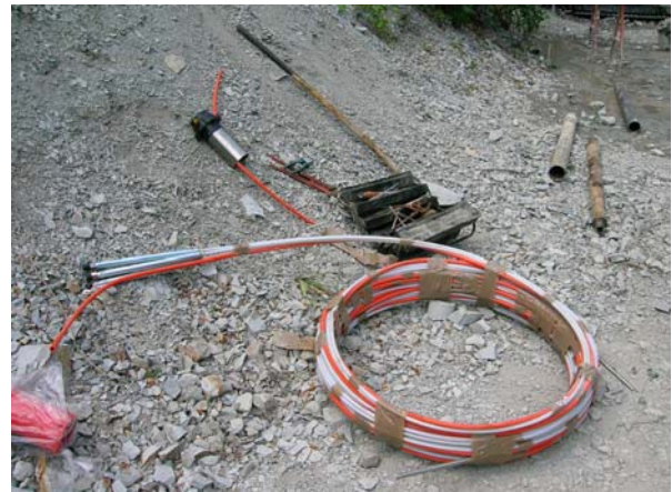
Sopra: particolare delle componenti da assemblare per l'installazione di estensimetro multibase.
