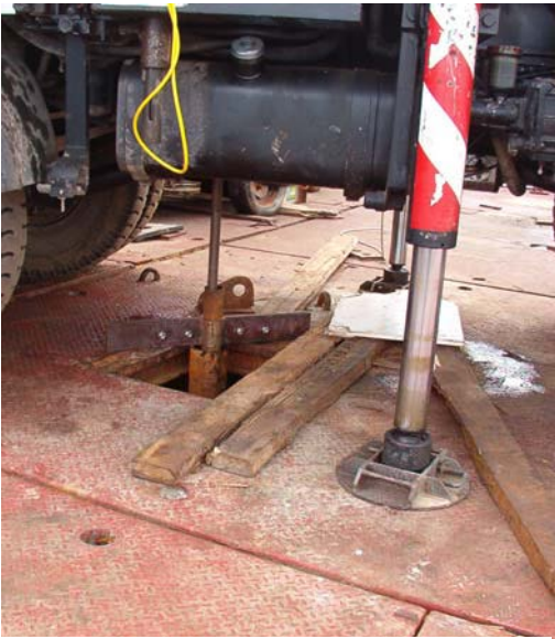
Esecuzione prove dilatometriche.
