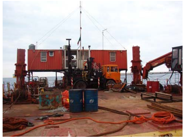
Allestimento della piattaforma con penetrometro e attrezzatura accessorio
