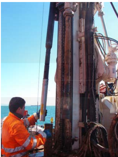
Esecuzione di perforazione verticale
