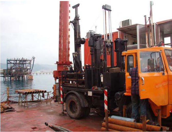
Esecuzione prove penetrometriche con cono sismico SCPTU
