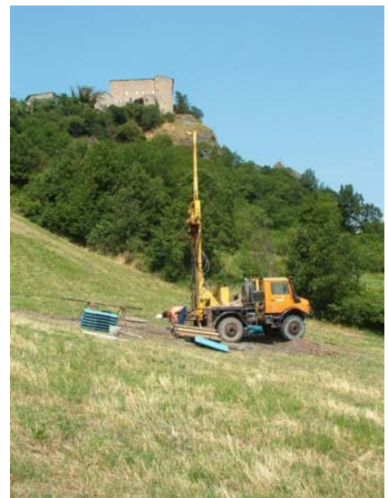
Perforazione a carotaggio continuo nel corpo di frana sottostante la rupe
