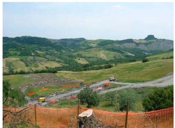
Panoramica degli Interventi di ripristino eseguiti al piede della rupe: pozzi drenanti e paratia di pali profondi.
