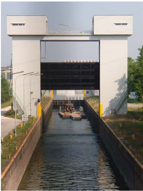
Penetrometro Pc90 su pontone galleggiante: superamento chiuse dell'avanconca del porto di Cremona. Prove penetrometriche CPT in alveo fluviale.
