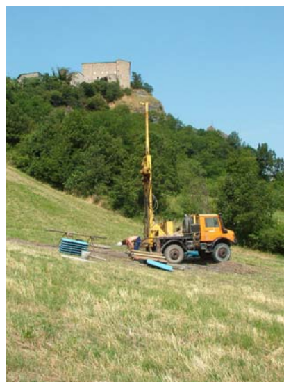
Perforazione a carotaggio continuo nel corpo di frana sottostante la rupe
