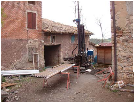
Perforazione a carotaggio continuo verticale nell'abitato di Rossena
