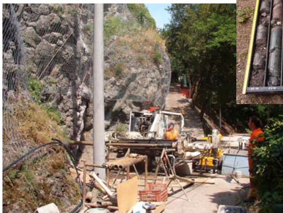
Perforazione a carotaggio continuo orizzontale nella rupe sotto il castello di Rossena
